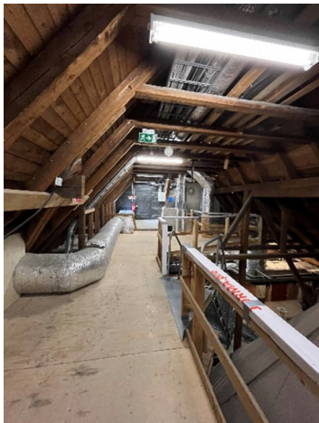
Kuva 5-6. Ullakko on tyhjennetty ja rakenteiden tukeminen aloitettu.
