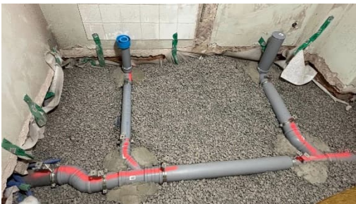
Kuva 13. Pohjakerroksessa on aukaistu lattiaita uusia viemäriinjoja varten.
