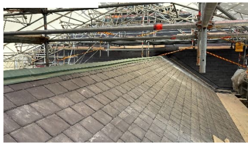
Kuva 7-8. Kattotyöt ovat edenneet hyvää vauhtia lohkolla 1. Vasemmalla peltikattoa ja oikealla liuskekivikattoa.
