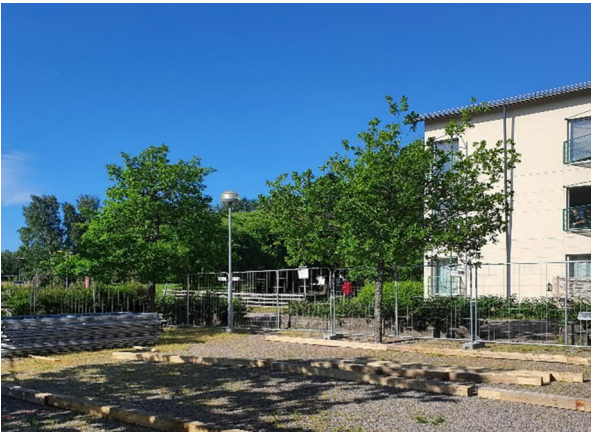
Työmaatiloihin liittyvät asennukset käynnissä Muusantorilla
