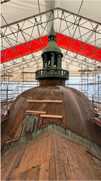
Kuva 3-5. Vesikaton purkutyöt ovat 1. lohkon osalta loppusuoralla.
