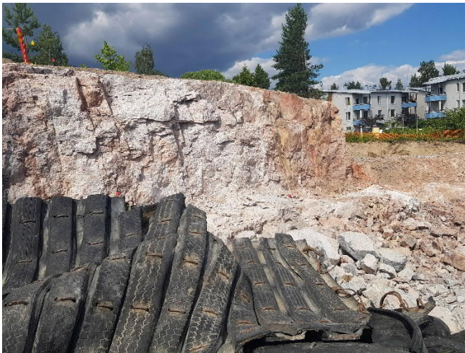
Valokuva louhitusta kalliosta 2.7.2021
