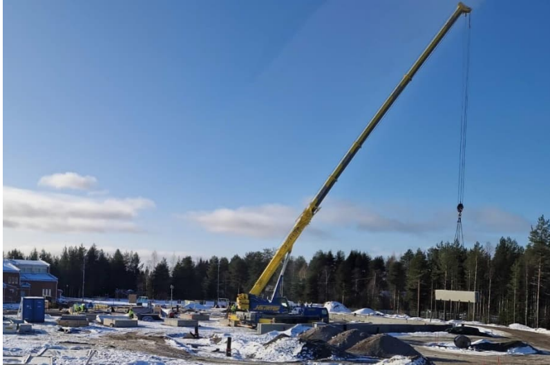
Kuva A-lohkon sokkelielementtien nostotyöt
