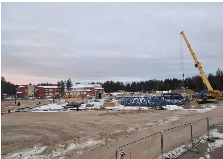
Kuva Torninosturin pystytys alkamassa
