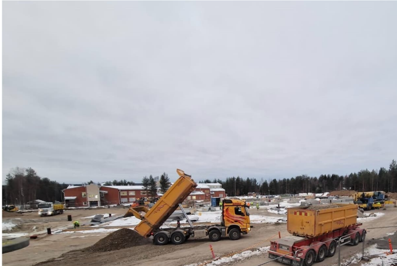
Kuva Yleisnäkymä työmaalta
