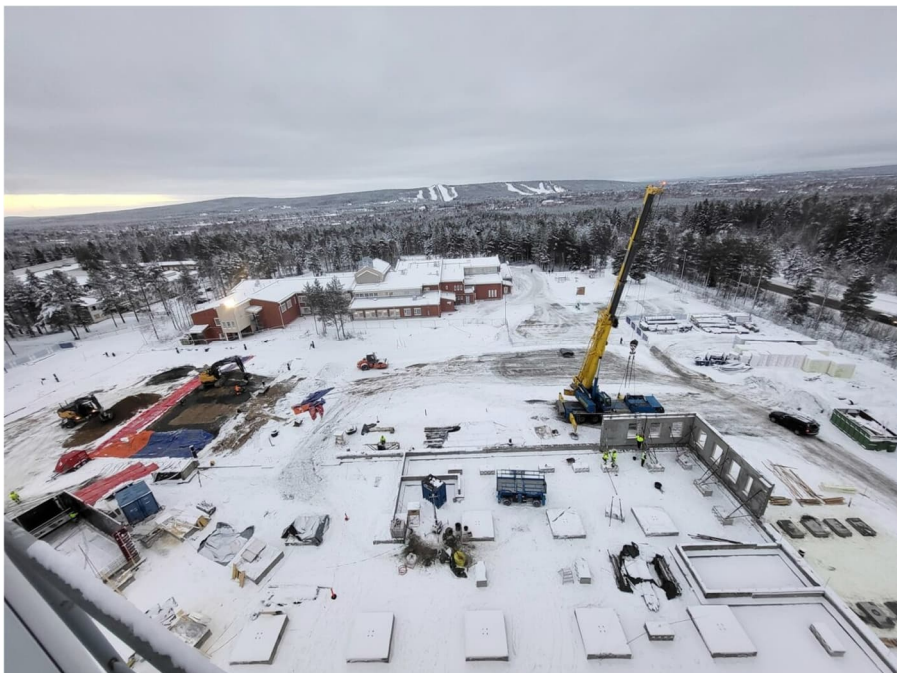
Kuva Työmaa ylhäältä päin kuvattuna
