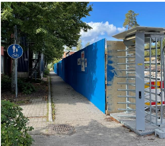
Kuva 1 Uusi työmaa-aita Muusanpolun puolella
